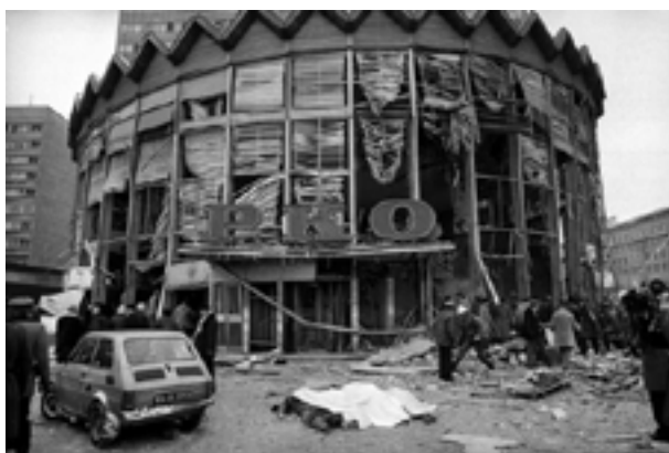
Fotografia 2. Widok Rotundy po wybuchu gazu
