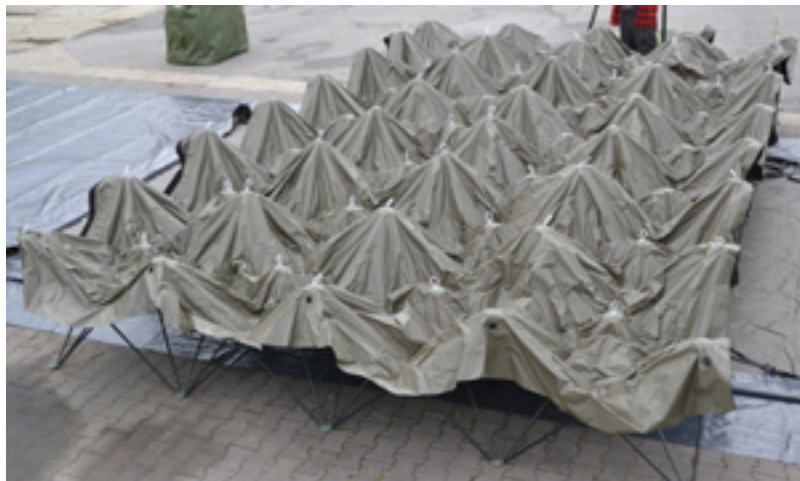
Ryc. 9. Namiot po rozciągnięciu stelaża – przygotowany do podniesienia
