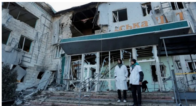
Fot. 5. Wołnowacha, Ukraina: zniszczony szpital
